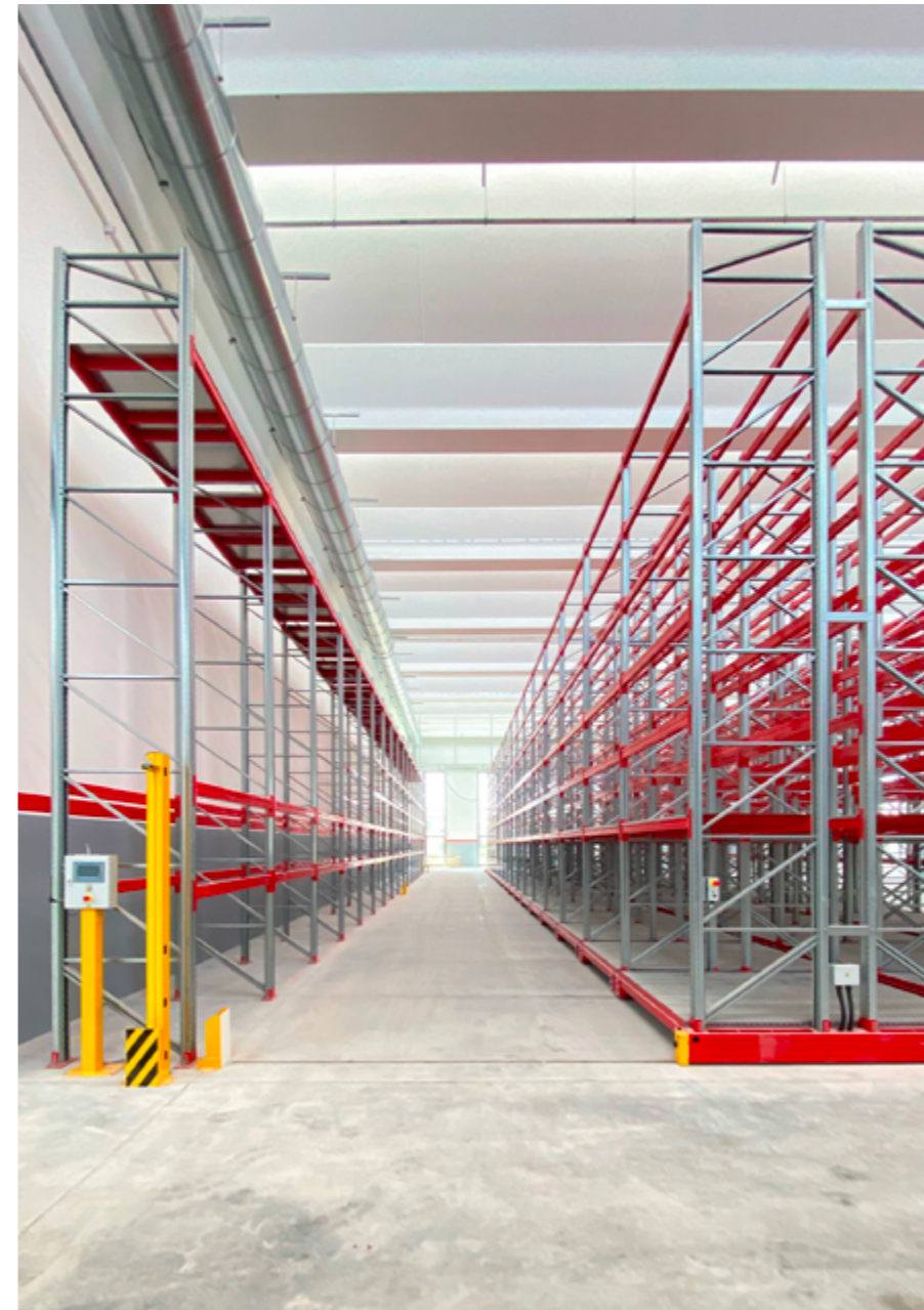
Verschieberegalanlage Mobile Pallet Racking
