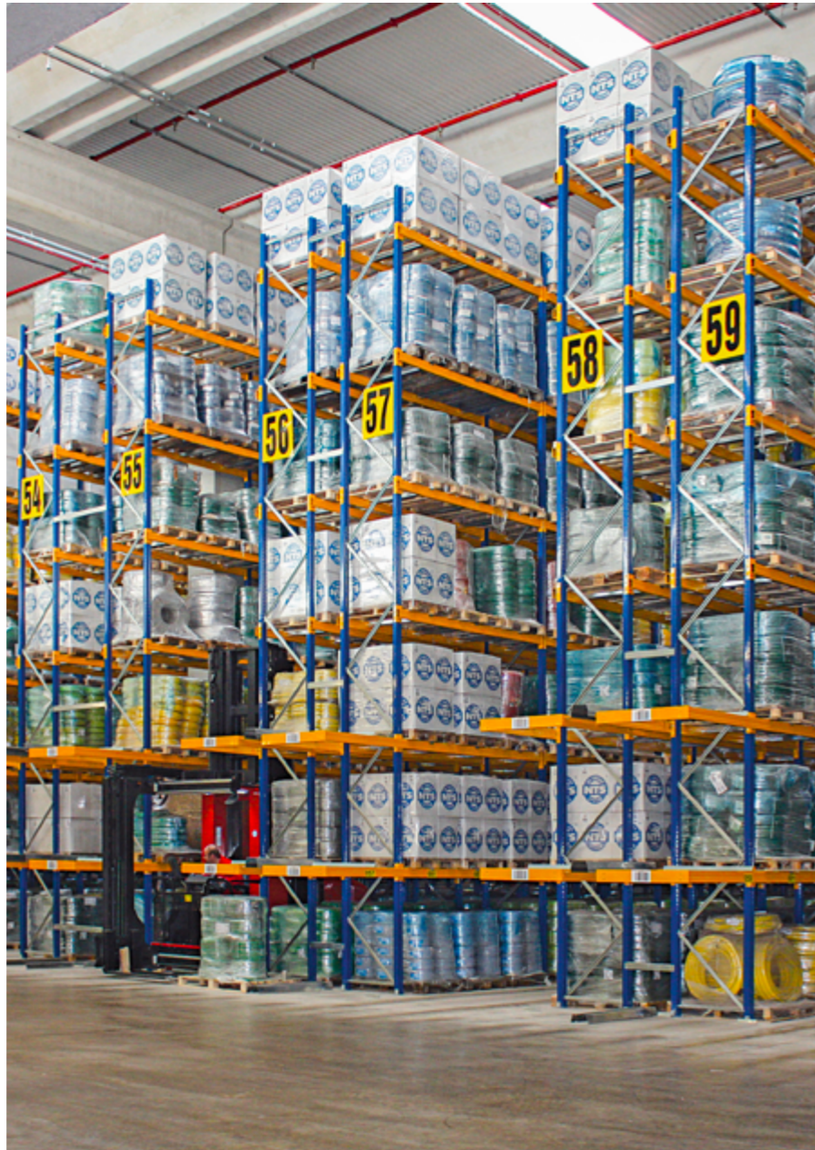
Palettenregalanlage mit Übergabestation Pallet Racking - with P&D loading bay
